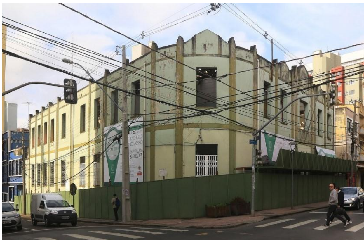
FIGURA 46. Antigo quartel em reforma, 2018.
