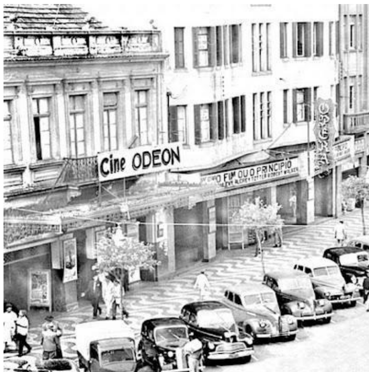
FIGURA 15. Cine Odeon, ao lado do Edifício Heloisa, com placa do Cine Ópera. FONTE: filmes.seed.pr.gov
