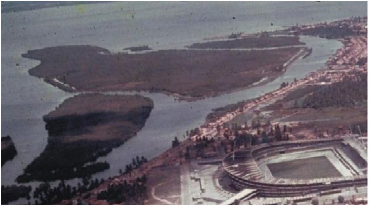
Figura 2: Canal do Trapiche
